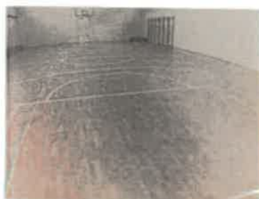
Podlaha je vyhovující.
